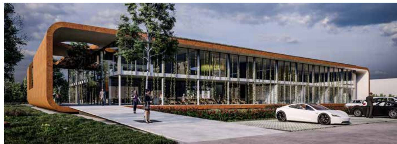
Voor de gevel is gekozen voor een stijlvolle combinatie van cortenstaal en vliesgevels (glasgevels).
